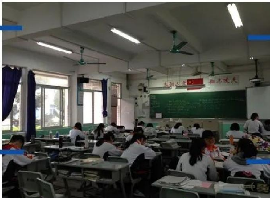
2 灯光外露，课桌面眩光值为25，高于国标要求的16，危害视力严重，危害视力
