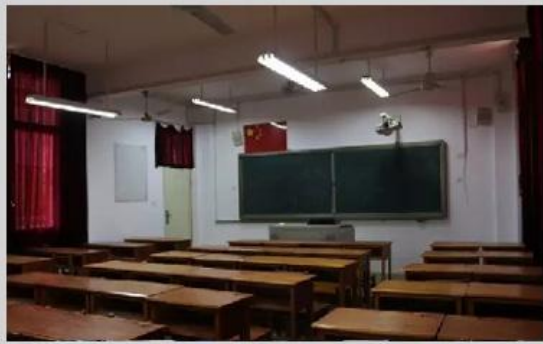
普通教室灯（照度均匀度差）
